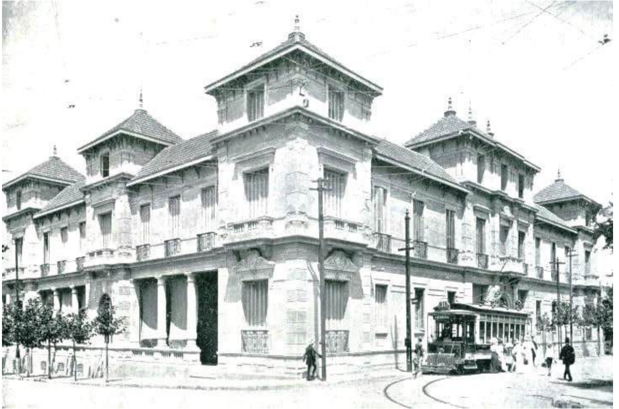
Figura 23. Hotel de los Pocitos, “primer establecimiento balneario de Sud-América” en constante mejora desde 1912 con su línea tranviaria ya electrificada de la “Sociedad Comercial de Montevideo” (Centro de Fotografía de Montevideo).
