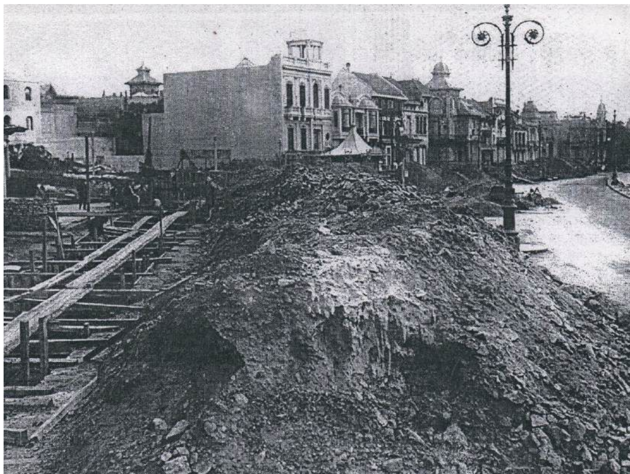
Figura 17. Caño maestro de Pocitos, a la altura de la Plaza Gomensoro, década de los 20's (Centro de Fotografía de Montevideo).
