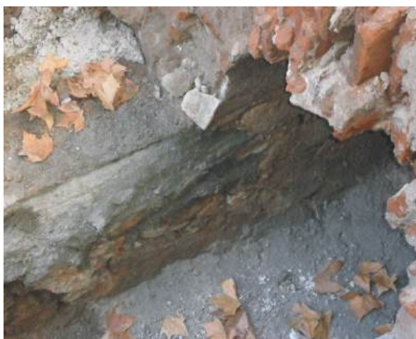
Figura 12. Caño maestro; piedra, revoque y ladrillo (Centro de Fotografía de Montevideo).
