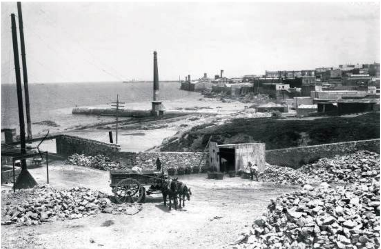
Figura 15. Chimenea de ventilación, calle Paraguay y Rambla (Centro de Fotografía de Montevideo).
