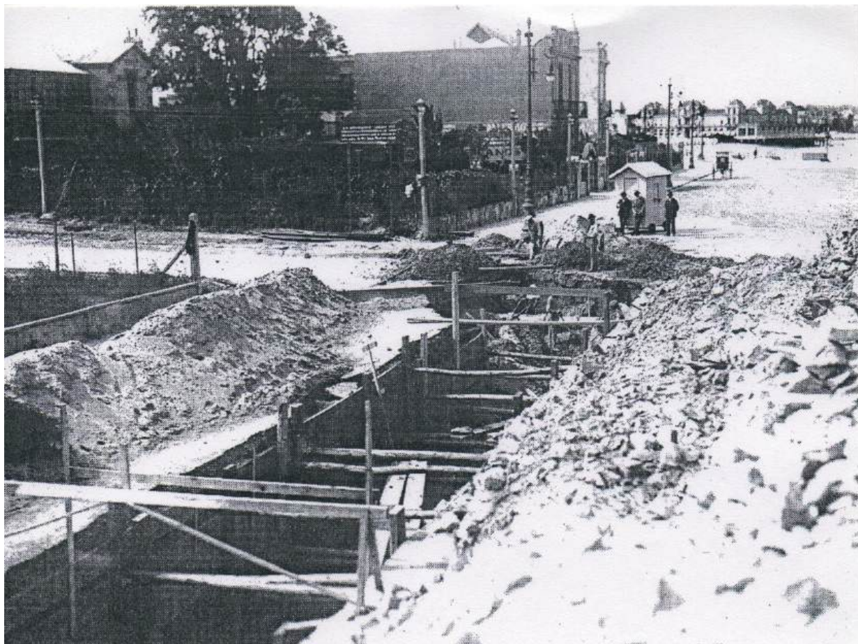
Figura 18. Caño maestro de Pocitos a la altura de Rambla y Solano Antuña (Centro de Fotografía de Montevideo).
