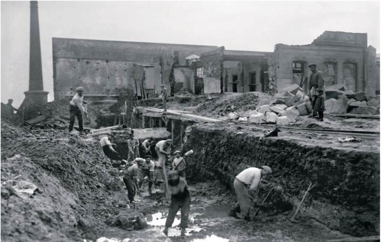
Figura 14. Chimenea de ventilación del colector principal, calle Guaraní durante la construcción de la Rambla Sur entre 1923-1935 (Centro de Fotografía de Montevideo).
