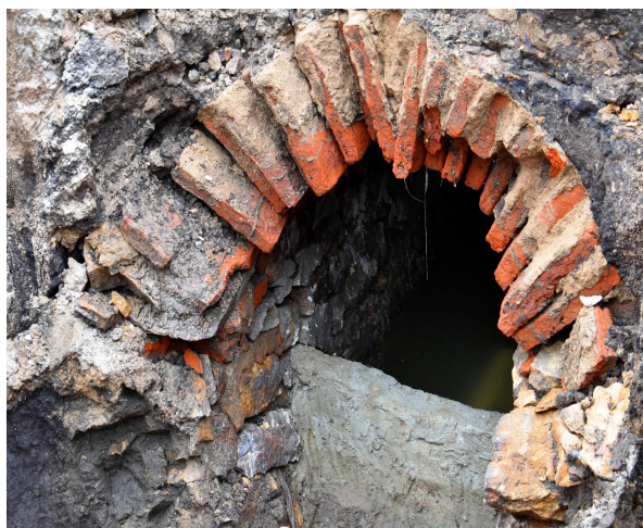
Figura 10. Bóveda ladrillo colorado (Centro de Fotografía de Montevideo).
