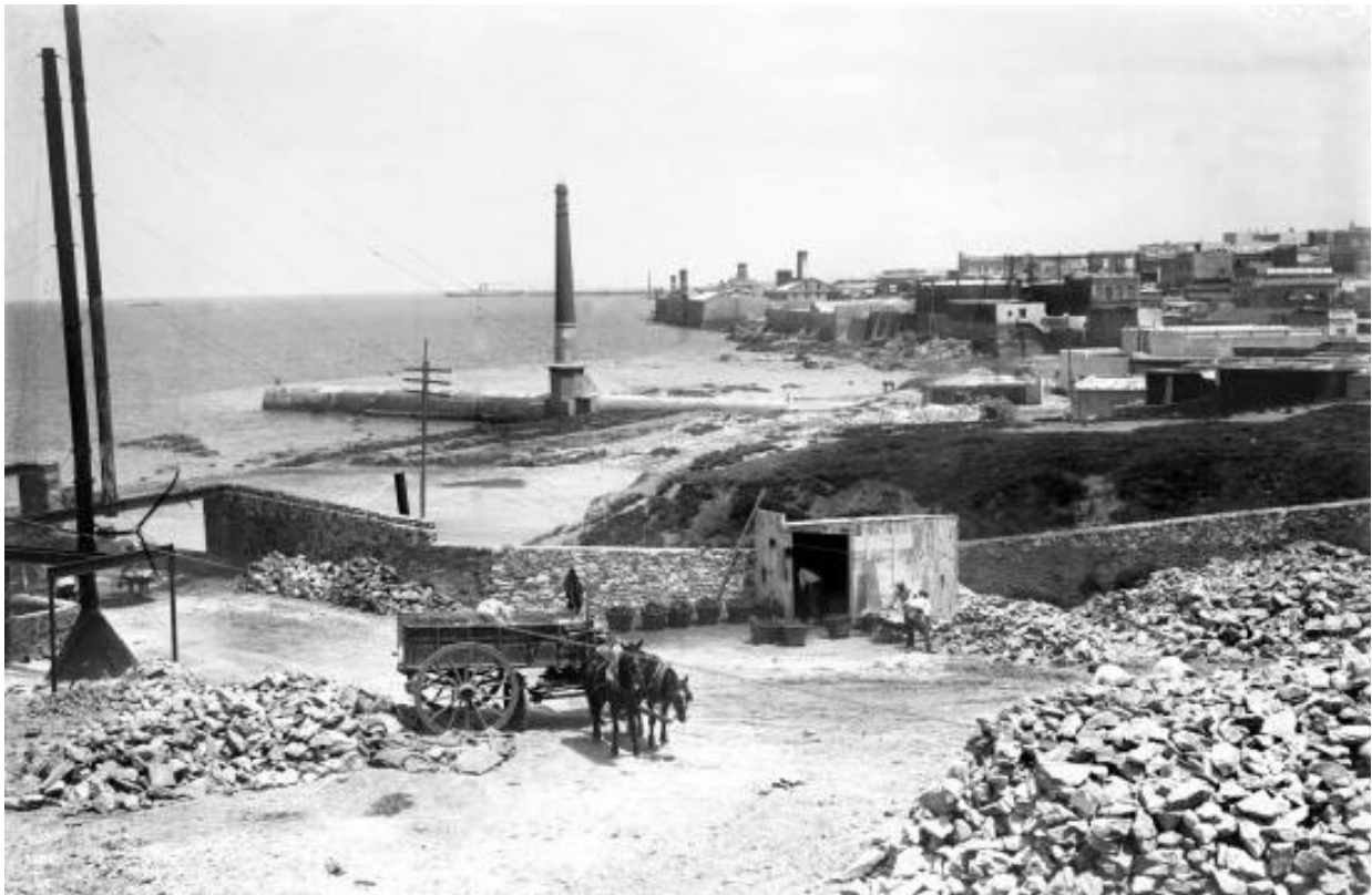
Figura 15. Chimenea de ventilación, calle Paraguay y Rambla (Centro de Fotografía de Montevideo).
