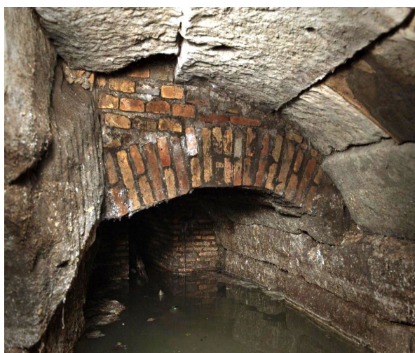
Figura 11. Colector principal (Centro de Fotografía de Montevideo).
