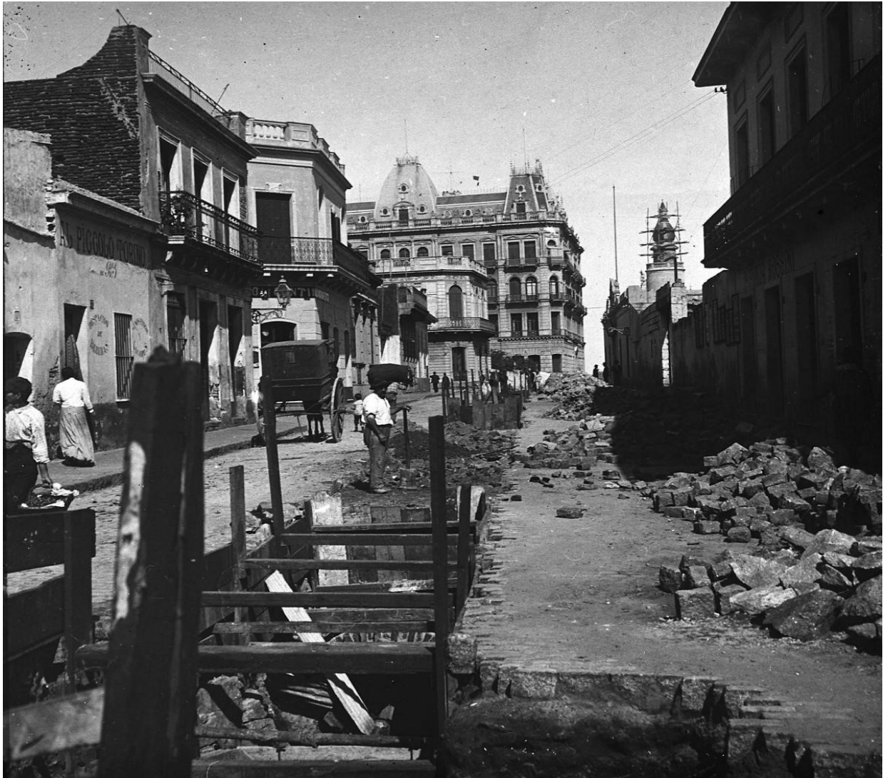
Figura 13. Colector secundario de la calle Guaraní. Al fondo el Hotel Nacional (fotografía de Jesús Cubela, Centro de Fotografía de Montevideo).
