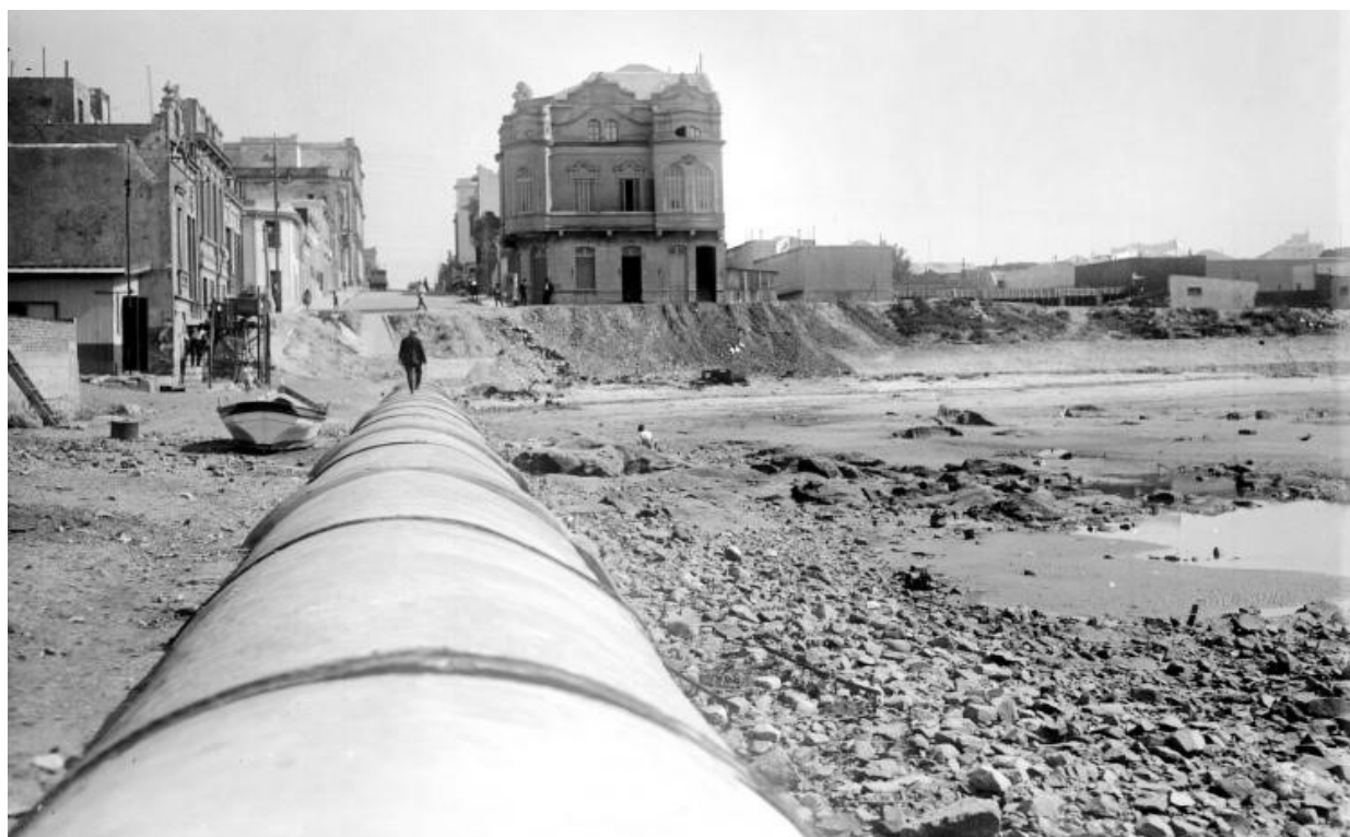
Figura 24. Tubería en hormigón, calle Magallanes (Centro de Fotografía de Montevideo).
